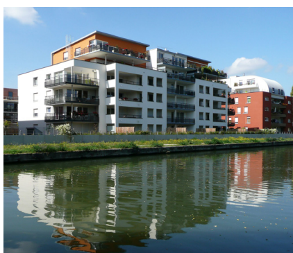
Architecte Mijolla Monjardet
